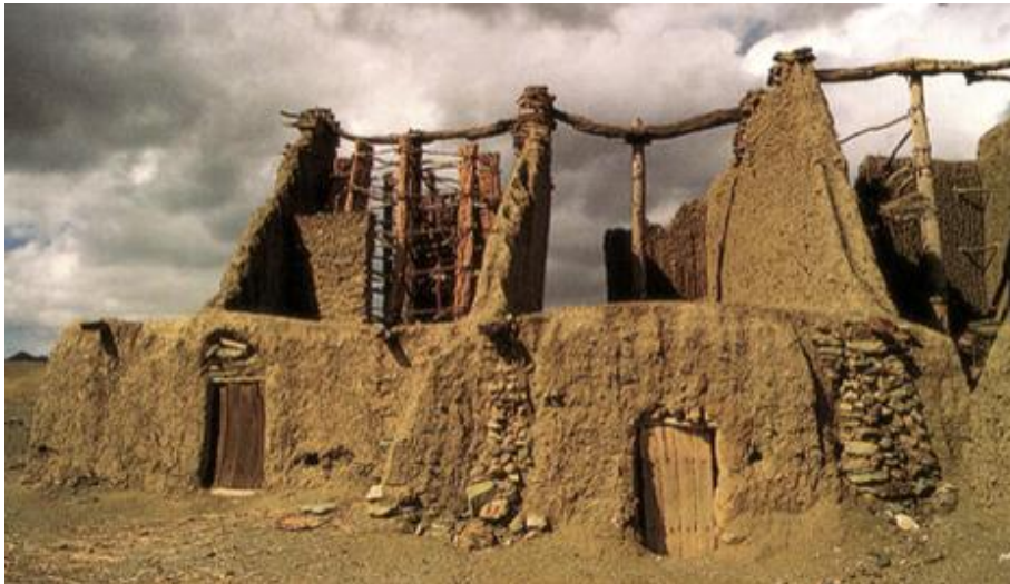
Вертикально-осевая мельница для измельчения зерна, Афганистан, (650 нэ)
